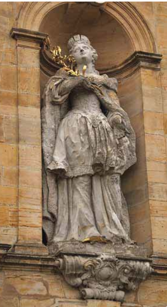
Bild 7 Kaiserin Kunigunde (~980–1033) aus dem luxemburger Grafenhaus auf der rechten Seite der Hauptfassade der Basilika. Die Figur ist aus einem einzigen Rohling aus Eisensandstein von Adlitz gehauen und mit Bleiweiß überstrichen.
