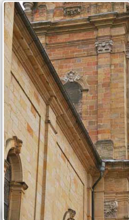
Bild ④ Stark rötlich oxidierter Eisensandstein am Ostturm der Basilika.
